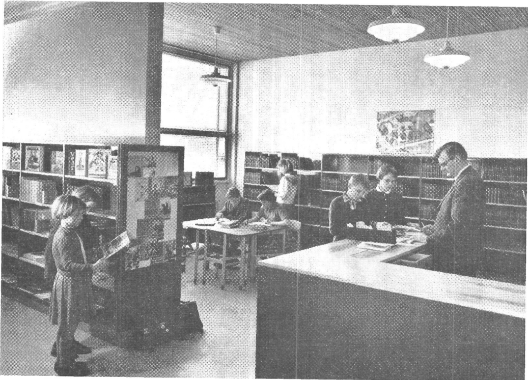
Udlån. Skilleveggen til venstre har ikke kunnet undgås, men er udnyttet ved udformningen af en særlig afdeling for små børn. Enden af reolen er udnyttet til opslagstavle.
